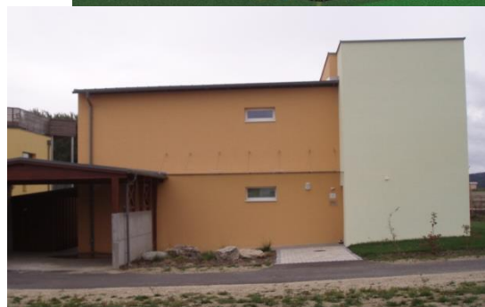
Nordseite eines Passivhauses kleine und wenige Glasflächen
