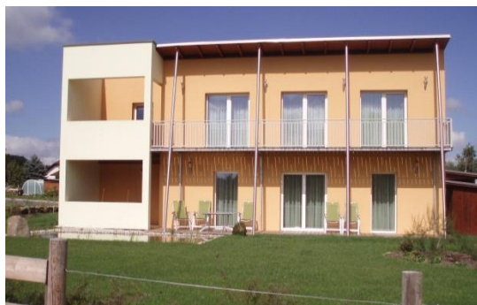
Südseite eines Passivhauses große Glasflächen
